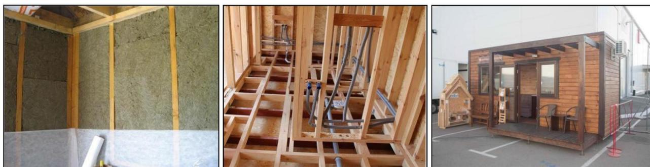
I muri interni sono composti da cremagliere 100 mm riempiti di lana di vetro 100 mm, rivestiti da tutti i due lati da telo vapore, guide di montaggio 30 mm e da perline di legno 15 mm
